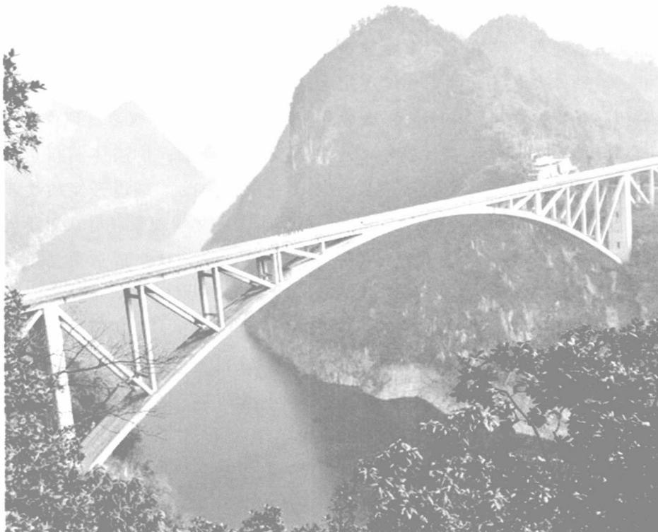
在当年红军强渡乌江的江界河上，一桥飞架南北。大桥主孔桥型为贵州省首创的预应力混凝土桁式组合拱，边孔为桁式刚构，主孔跨径330米，居世界混凝土桁式桥梁之首。大桥全长461米，宽13.40米，高263米，1995年6月竣工通车，1997年获国家科技进步二等奖、中国建筑工程鲁班奖。（王正澜 摄）
