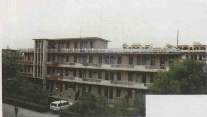
▲ 海洋与水产局办公楼
