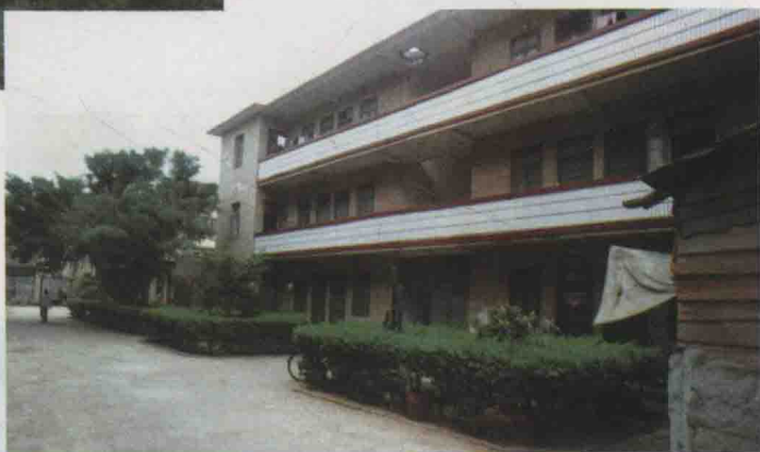
▲ 县水技站办公楼
