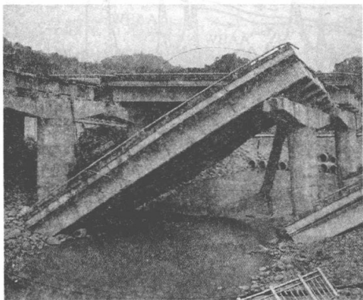
图 1-3 台湾 1999 年集集大地震造成桥梁倒塌
