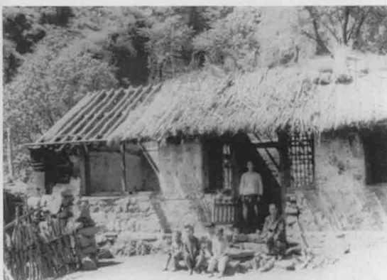
日本侵略者在建昌境内集家并村修筑的“人圈”和“人圈”内的民房
