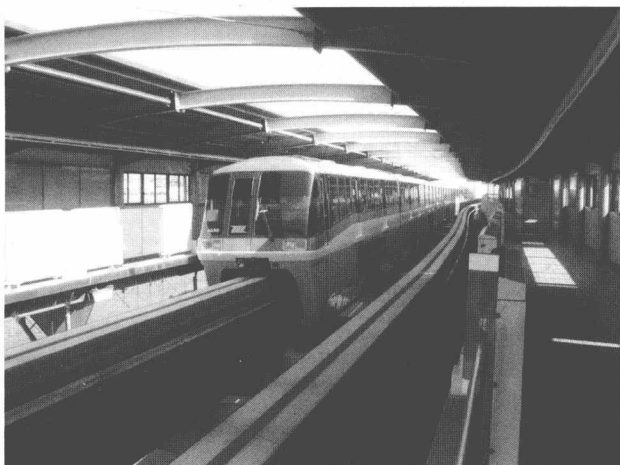
图 1-2-2 日本东京跨座式单轨交通
