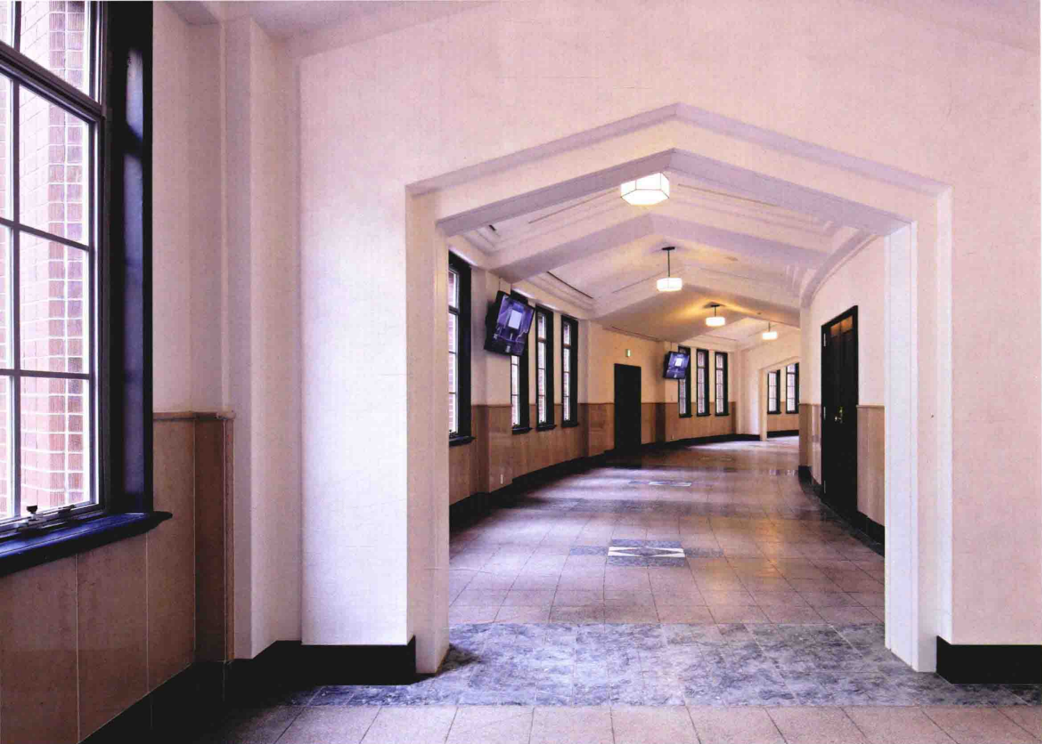
3层走廊视角。增设门形钢筋护板框架，以提高抗震强度
