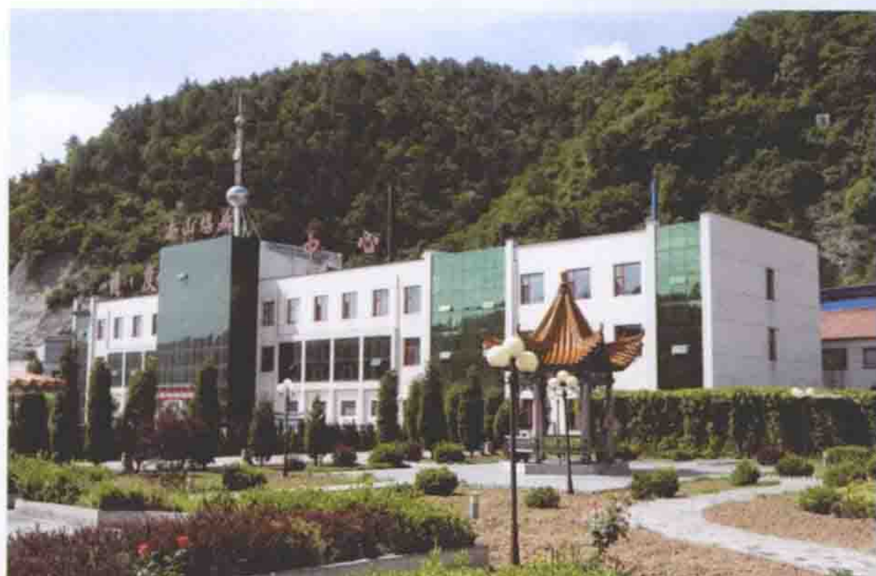
南山煤业公司调度楼
