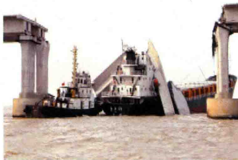
图1-1-16 浙江宁波在建金塘大桥被船撞塌
