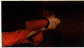
(2) 将带软布的木塞塞进破洞
