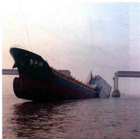
图1-1-16 浙江宁波在建金塘大桥被船撞塌
