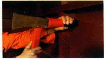
(3) 用锤子将木塞打进破洞
