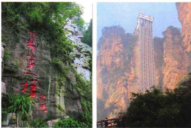
百龙观光电梯工程气势宏大，垂直高差335米，运行高度326米，由154米山体竖井和172米贴山钢结构构成，采用三台双层全暴露观光电梯并列分体运行。每台一次载客47人，运行速度3米/秒，三台同时运行每小时往返运量达3000人次。
