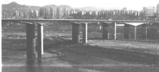
图 1.2 重庆长江大桥复线桥(2006年)
