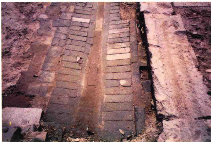
图 284 南宋灵隐寺法堂遗址砖砌散水
