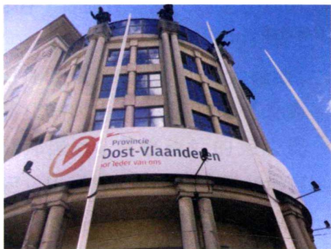
图3 东佛兰德省政府部门办公大楼
