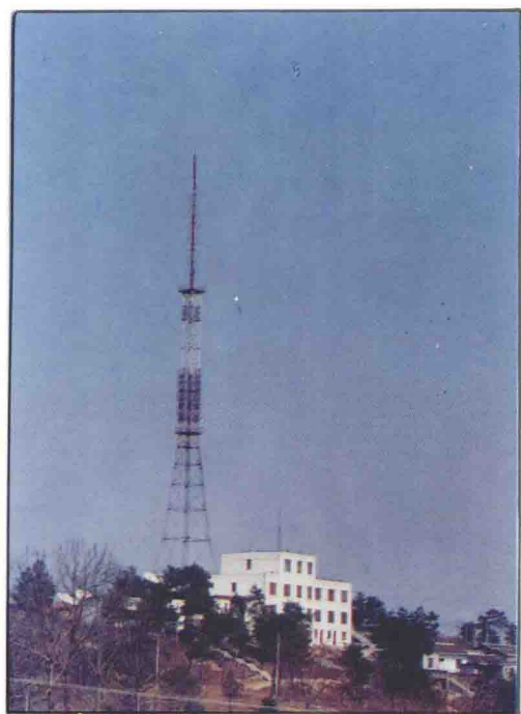
△ 弋阳电视台,弋阳教育电视台机房和发射铁塔。1991年竣工(杨明贤摄)。
