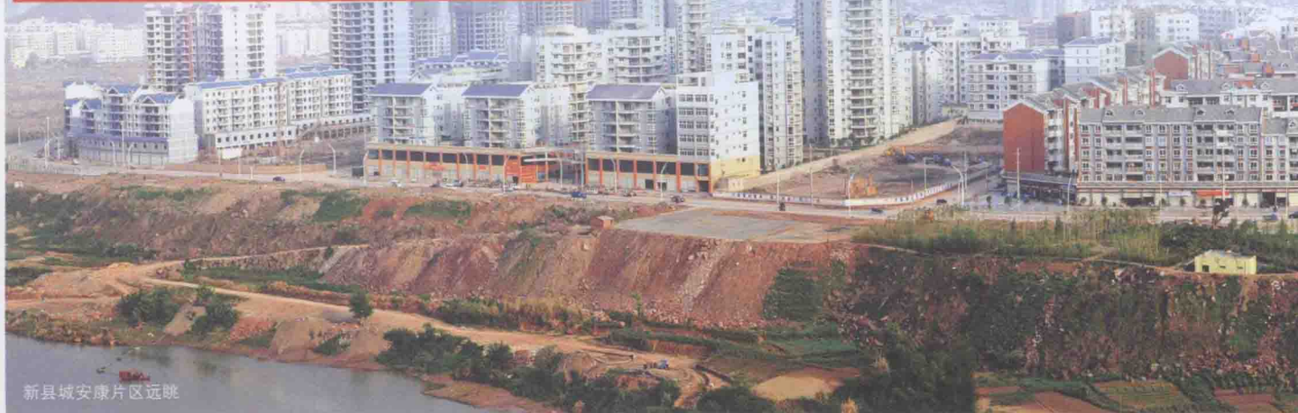
开县水位调节坝工程开工建设
