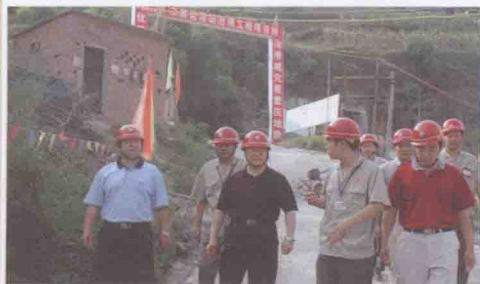
局党委书记、局长杜顺义深入三峡库区地质灾害治理工程施工现场检查工作
