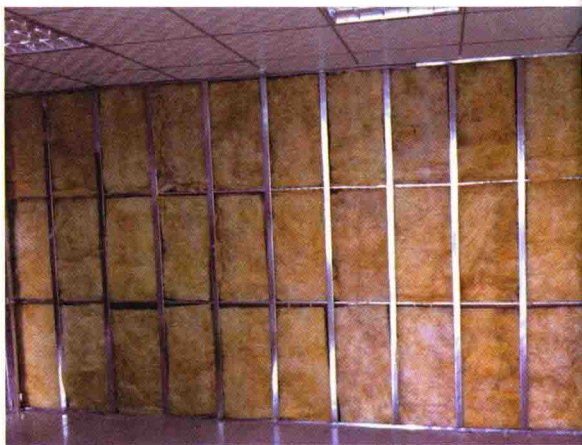
图 1-5 轻钢隔断隔墙夹上吸音棉
