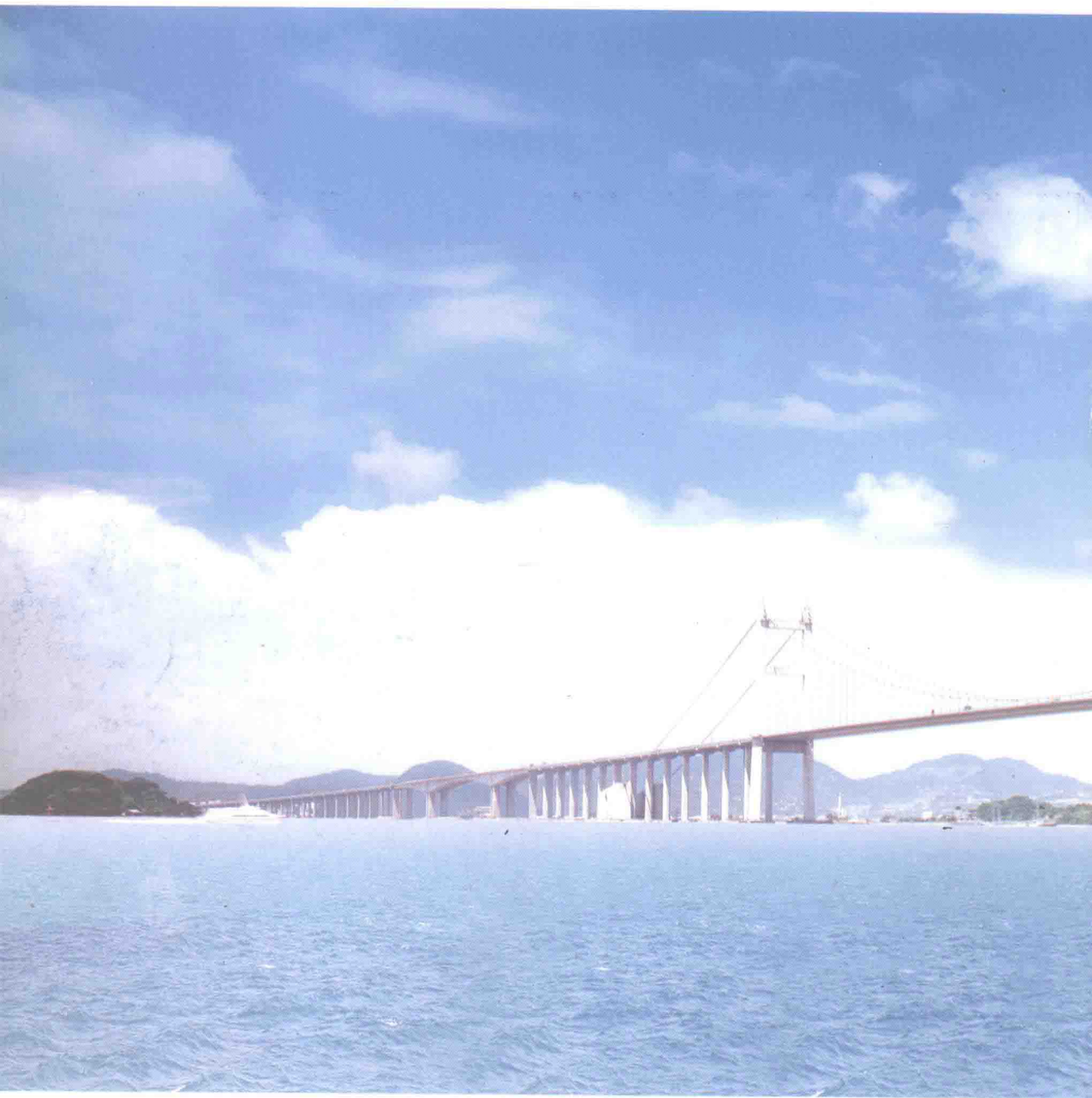
虎门大桥，全长 4.6km，主航道桥为国内迄今已建成工程规模最大的主跨 888 m 悬索桥，图右下方为著名的威远炮台
