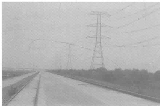
图 1-3 500kV 双回四分分裂输电线路
