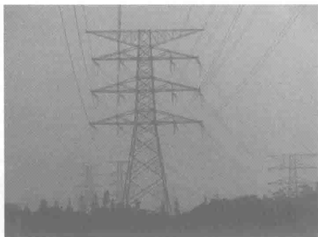
图 1-5 220kV 四回输电线路
