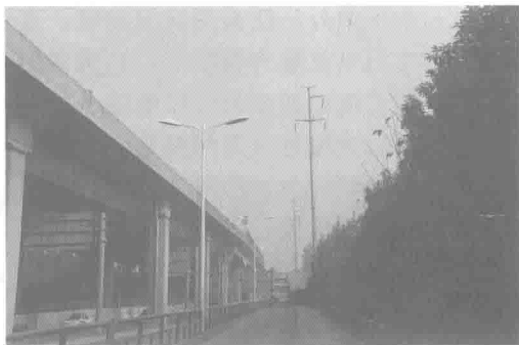
图 1-6 110kV 单回钢管杆输电线路
