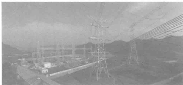
图 1-1 施工中的 1000kV 特高压交流双回八分裂输电线路
