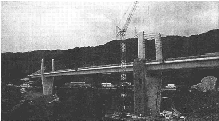
图 1-10 日见桥（Himi Bridge）
