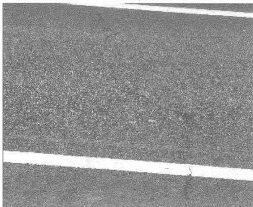
图 1.2-1 不规则反射裂缝
