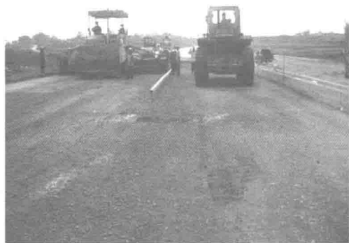
图 1.2-4 半刚性材料表面松散
