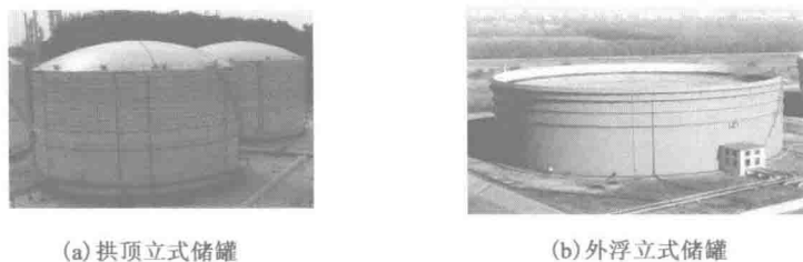
图 1-2 立式储罐的结构形式
