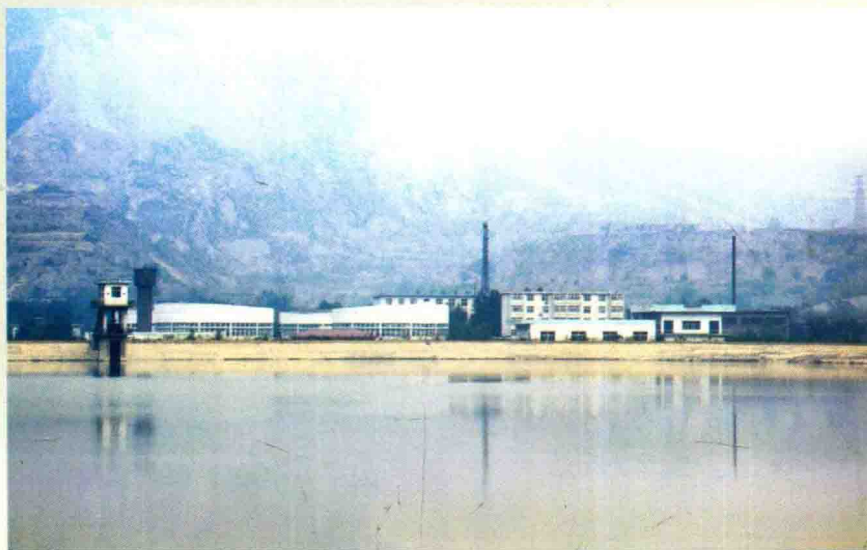
容量为 127 万立方米的河津工业调蓄水池
