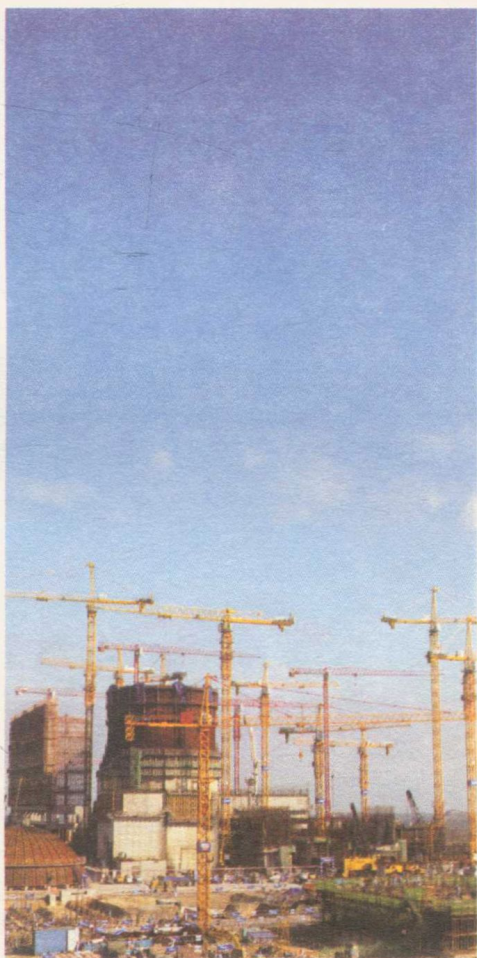
建设中的核电站
