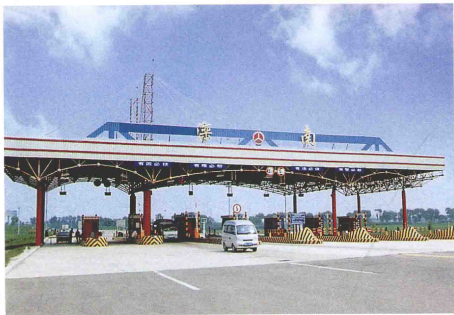
△ 唐港高速公路滦南出（入）口
