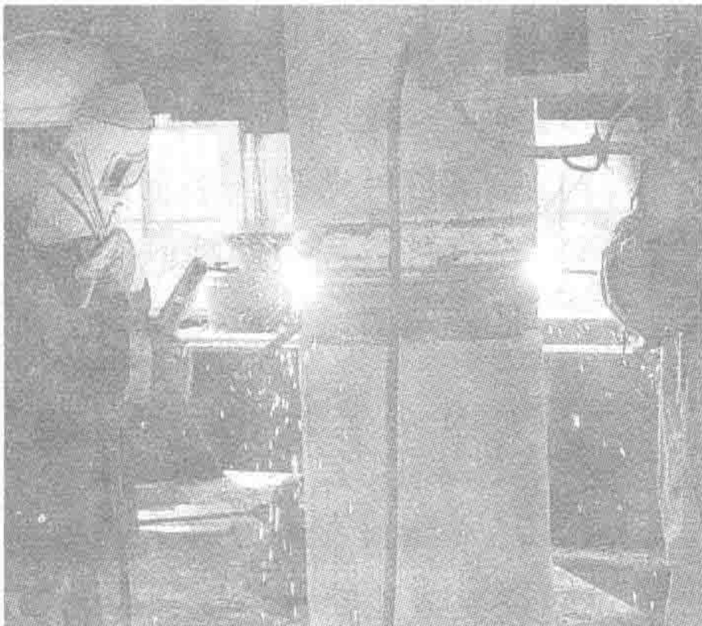
图 1-2 双人对称焊接符合要求
