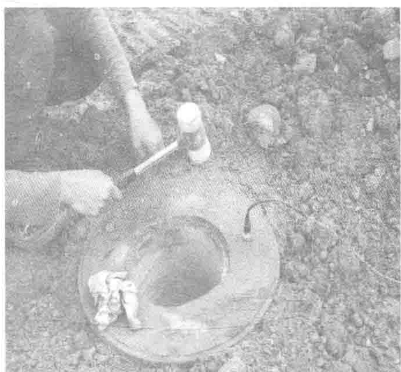
图 1-6 管桩小应变检测
