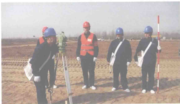
图 1-4 电杆基坑定位
