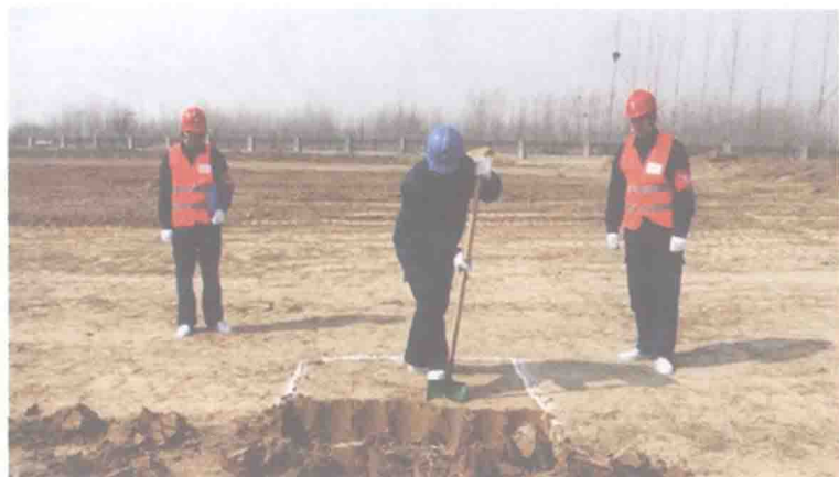
图 1-5 电杆基坑开挖
