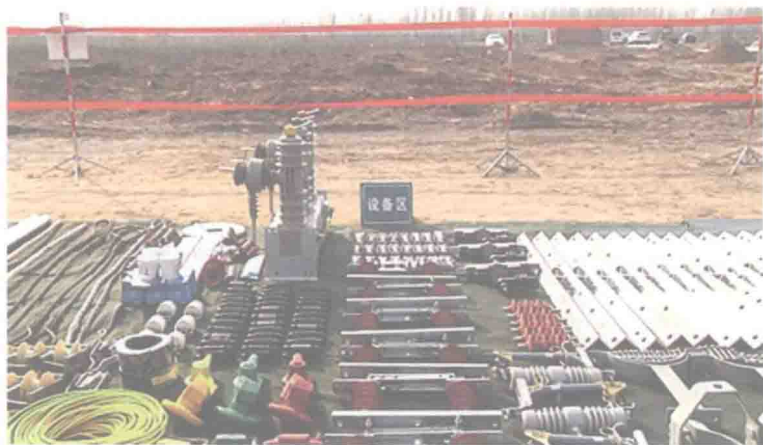
图 1-3 现场工器具材料分区放置
