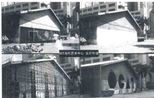
OCAT 建筑外观变迁对照图
