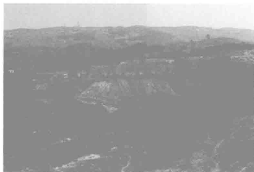
图 1-4 张家坪滑坡全貌(治理后)
