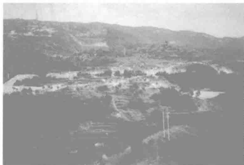
图 1-3 张家坪滑坡全貌(治理前)
