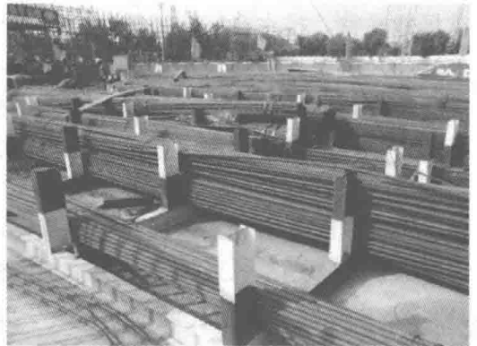
图 1-21 钢筋堆放示意图
