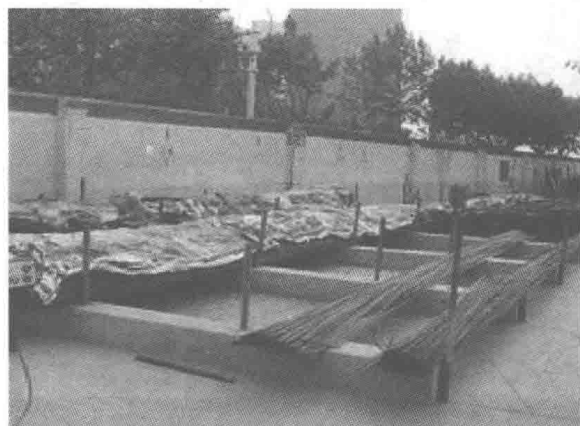
图 1-7 钢筋原材堆放区下浇筑混凝土台，便于通风排水
