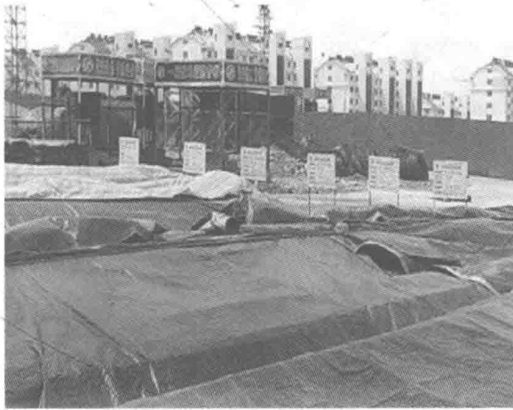
图 1-13 材料整齐，有防雨措施
