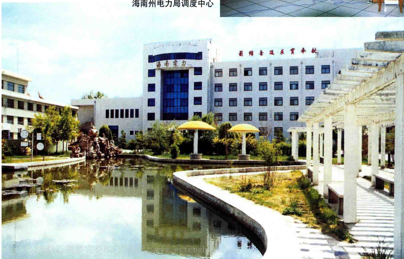
电力局办公大楼
