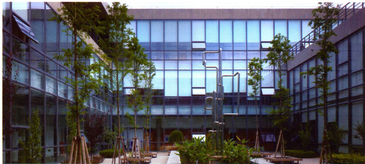
校区综合行政楼
