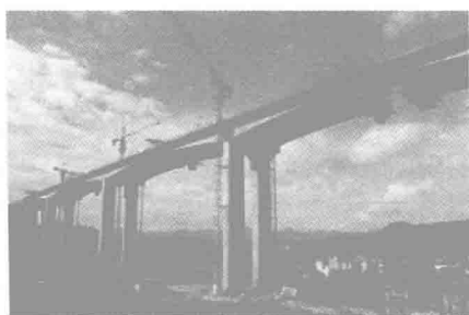
a) 龙坊高架桥
