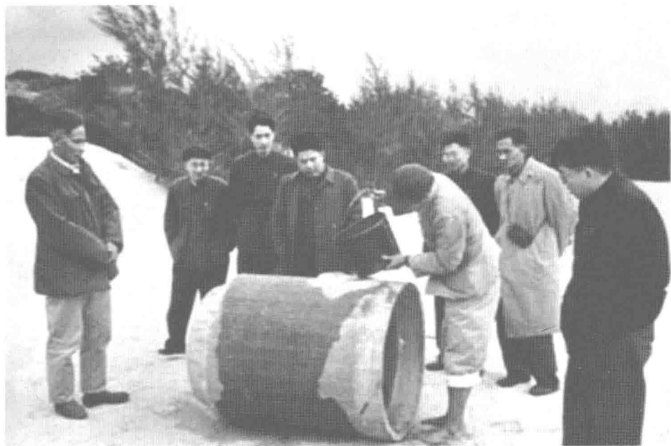
1963年2月，谷文昌（左一）在湖尾地下水工地与工程技术人员一起试验滤水管。
