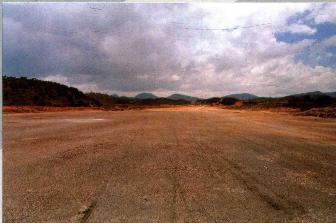
正在施工中的惠澳(疏港)公路——三栋路段
