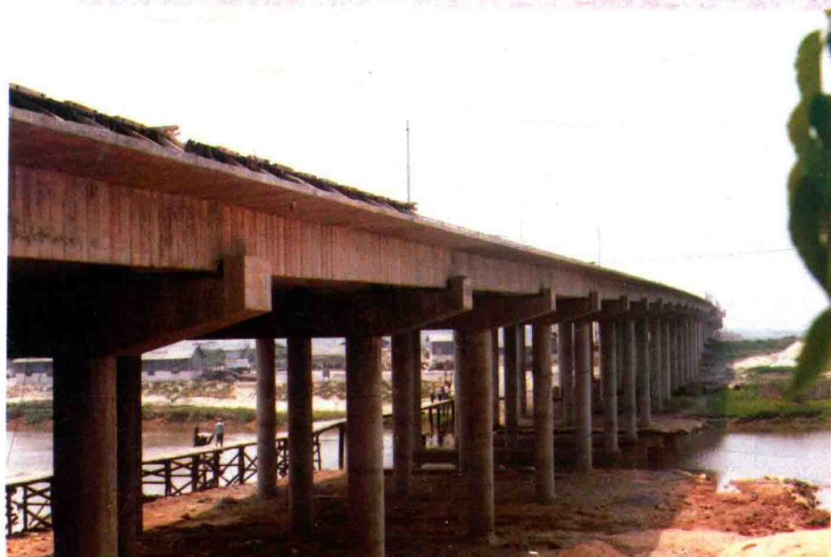
正在施工中的罗浮山东江大桥
