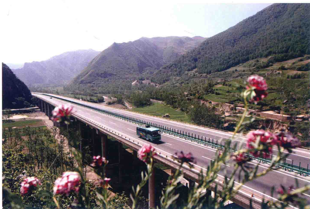
西宁至湟源一级公路湟源峡段 2001 年开工建设,2003 年 9 月建成使用。
