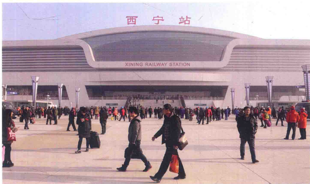
2010年4月西宁火车站改造工程启动,2014年12月25日零时,西宁火车站正式建成并投入使用,2014年12月28日首列高铁正式通车运行。(祁国彪 摄)
