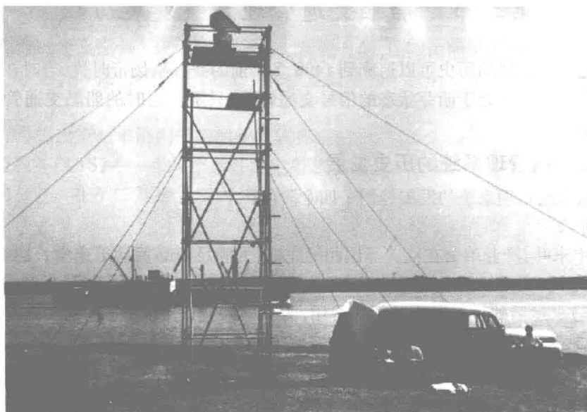
图 1-1 世界上第一个港口导航雷达站
