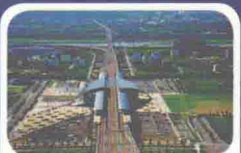
39 新竹站 Hsinchu Station
