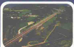
63 通霄路工工程 Tongsiao Embankment
