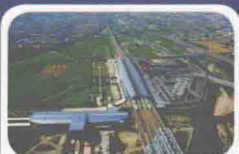
73 台中站 Taichung Station
