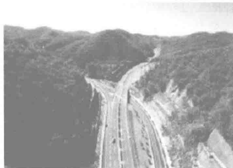
图 1-8 纵断面设计与原地形自然结合
