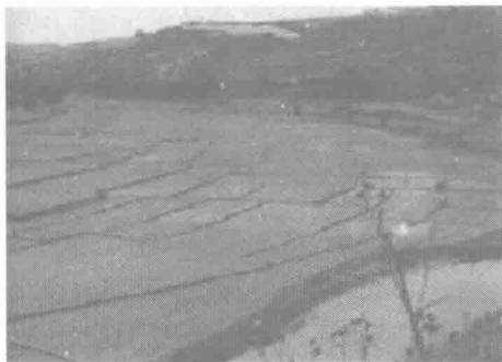
图 1-7 跨越耕地时降低路基高度
