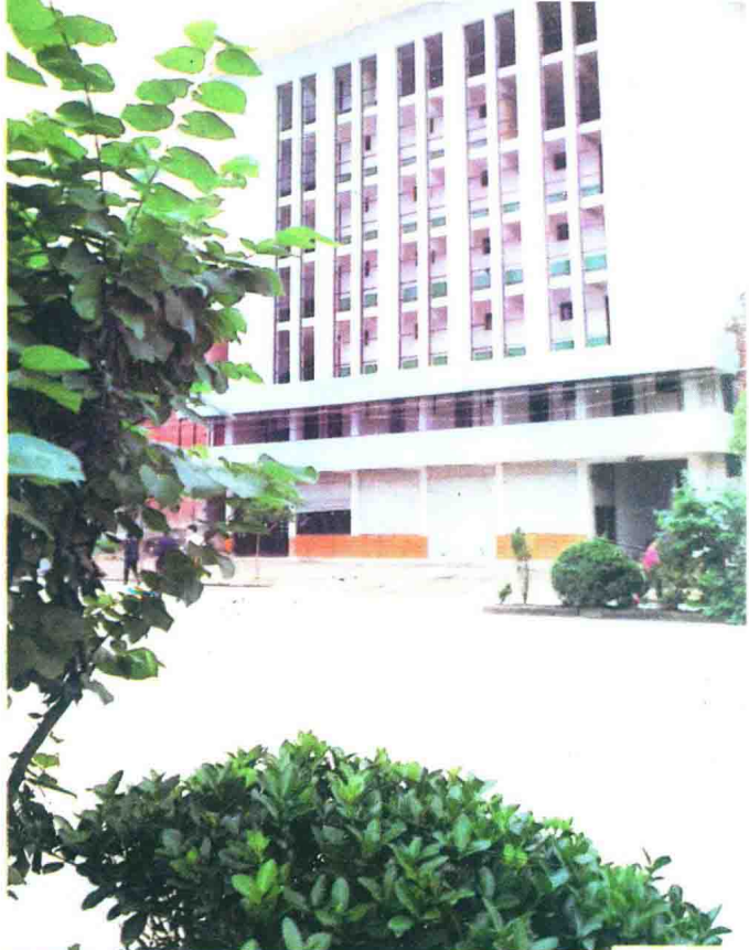
涪水县交通局综合大楼
