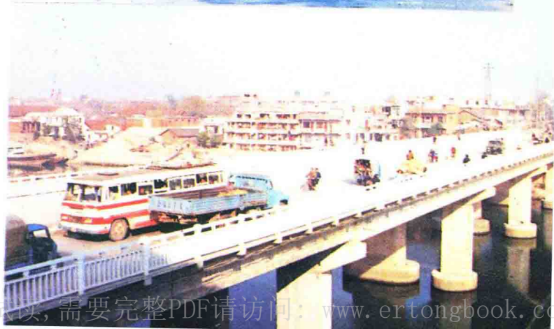
浠水公路大桥
