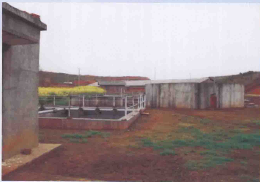
▲ 常宁荫田分公司污水处理厂一角
