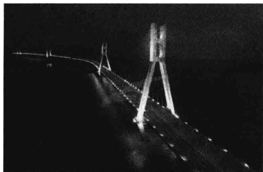
图1 江苏润扬长江大桥
