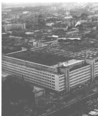
图1-1 位于莫斯科加里宁格勒(Kailiningrad)的实验机械制造中央设计局大楼
