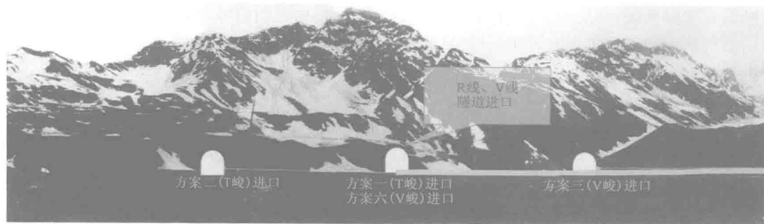
a) 隧道进口
