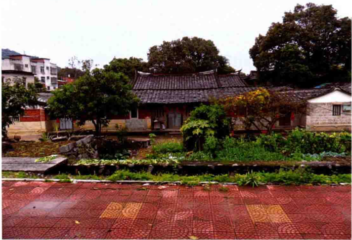
图12 泉州安溪龙门两边使用不同建筑材料的闽南红砖建筑
