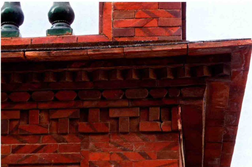
图26 厦门翔安洪厝清末红砖建筑的屋檐
