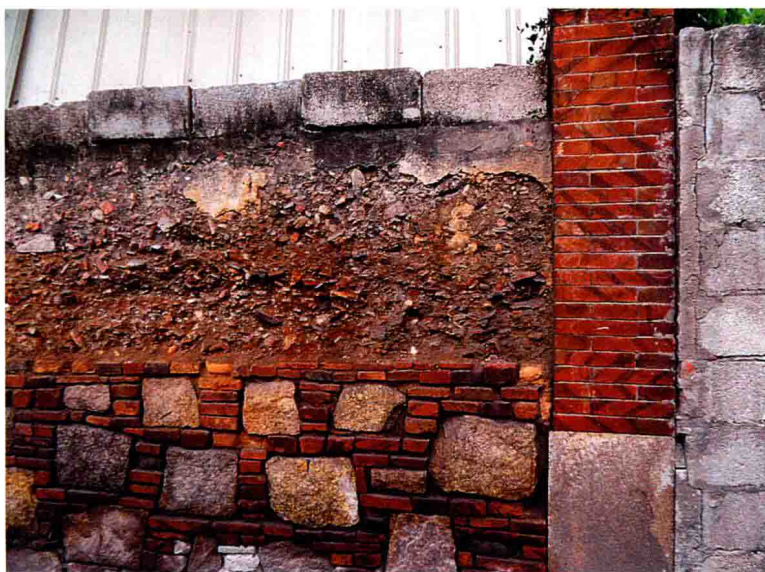
图22 泉州一处红砖建筑的出砖入石墙壁
