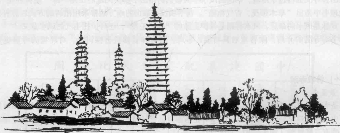
图3-004 未改建前崇圣寺三塔外景（1980年）
