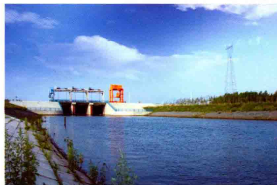
北引渠首进水闸前嫩江
