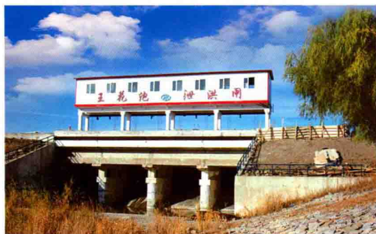
王花泡滞洪区泄洪闸
