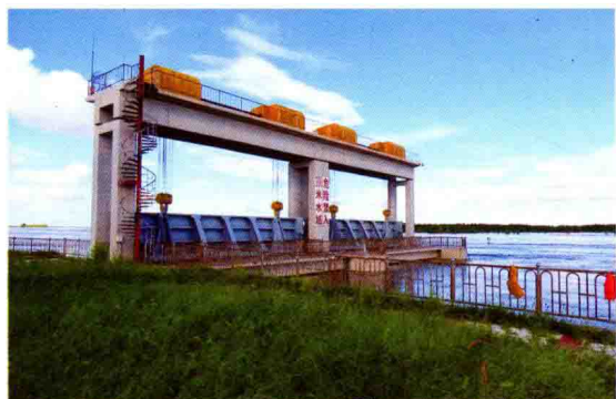
2013 年 8 月 17 日洪水嫩江齐齐哈尔橡胶坝副坝， 闸与水位关系
