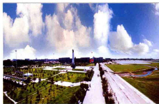
齐齐哈尔市嫩江堤防工程
