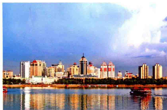
哈尔滨市松江堤防工程
