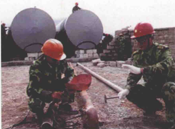
青藏兵站部某团高级工程师姚志祥（右） 在沱沱河兵站油罐改建工地 江宛柳 摄
