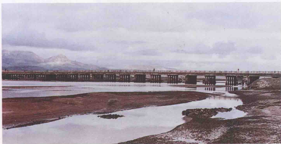
万里长江源头第一桥——青藏公路沱沱河大桥 青海省交通厅 提供
