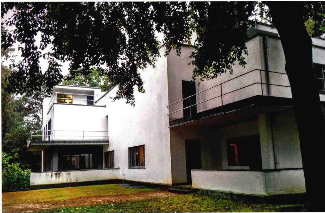
两德合并后，完全修复的康定斯基-保罗·克利住宅楼
