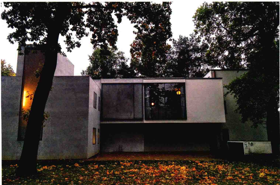
修复后的格罗皮乌斯住宅正立面
