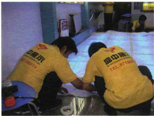
图 1-9 国内展示工程施工现场
