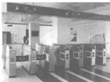
图 1.8 拍打门式检票机
