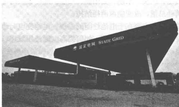
图 1-1 合肥市某电动公交车充电站场景
